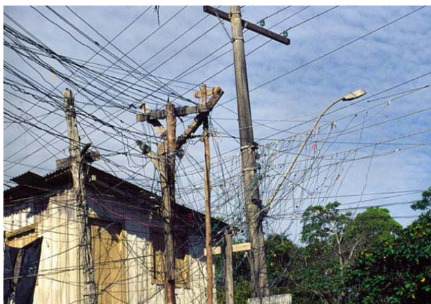
Figura 11 - Instalações elétricas clandestinas Fonte: SEHAB/HABI – 1999.
